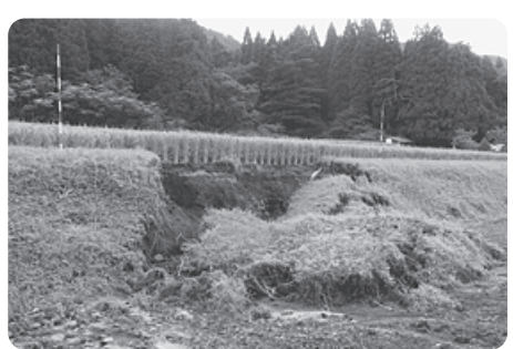
畦畔の崩壊 馬木地内
