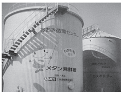
生ごみ・し尿等の発酵（大木町）
