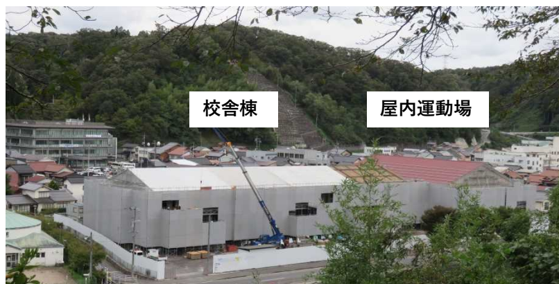
建設中の新校舎の様子
