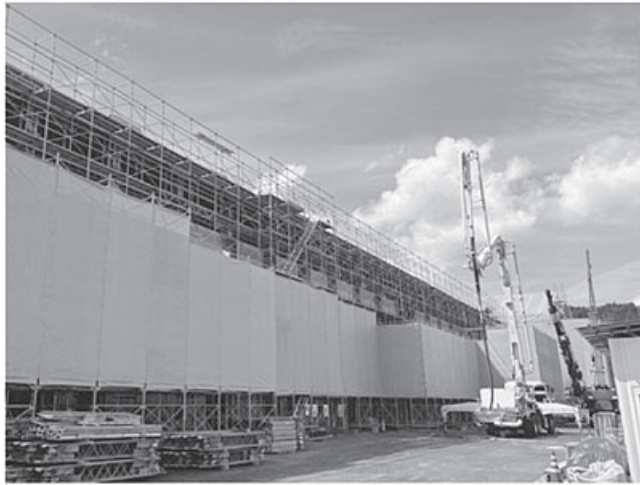
建築中の仁多小学校（9月下旬）
