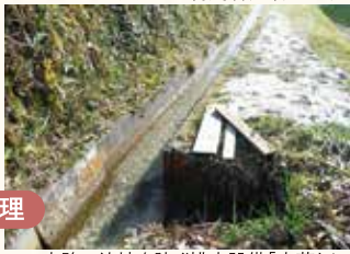
水路の決壊を防ぐ排水設備「水落とし」
