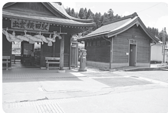
JR出雲横田駅トイレ改修事業 トイレ洋式化に要する経費
