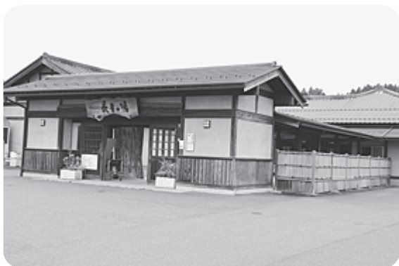
佐白地区交流拠点施設大規模改修事業 長者の湯測量設計監理、改修工事に要する経費
