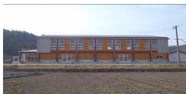
八川小学校屋内運動場
