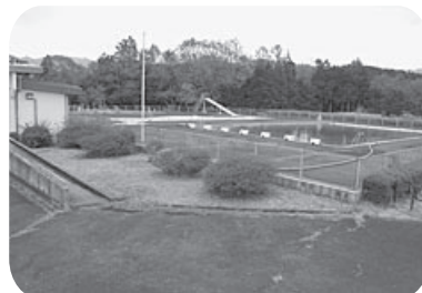
防災ヘリポート整備事業 防災ヘリポート整備に係る測量設計(横田公園プール跡地) 800万円
