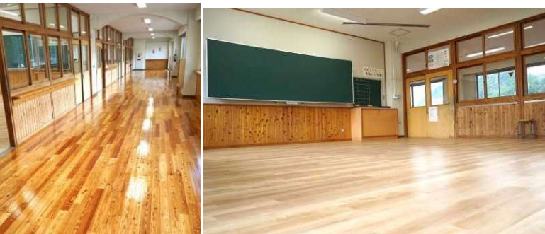
きれになった廊下 改修後のクラスルーム (床改修、黒板更新、照明LED化)
