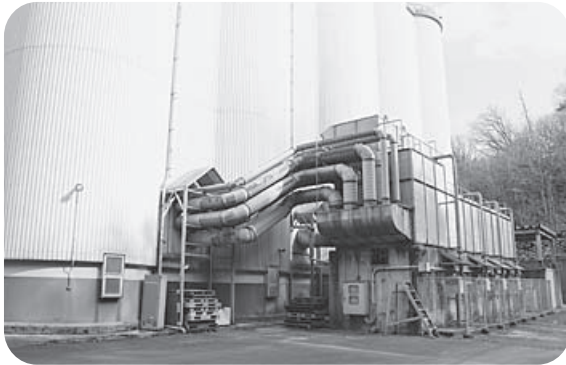
カントリーエレベーター設備更新事業 仁多郡カントリーエレベーター（米乾燥調製貯蔵施設） の施設・設備更新 1億1400万円
