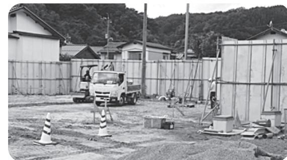
三成小学校仮設校舎工事の状況（9月）
