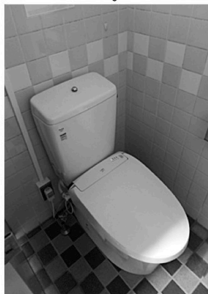
洋式に改修された1階男子トイレ
