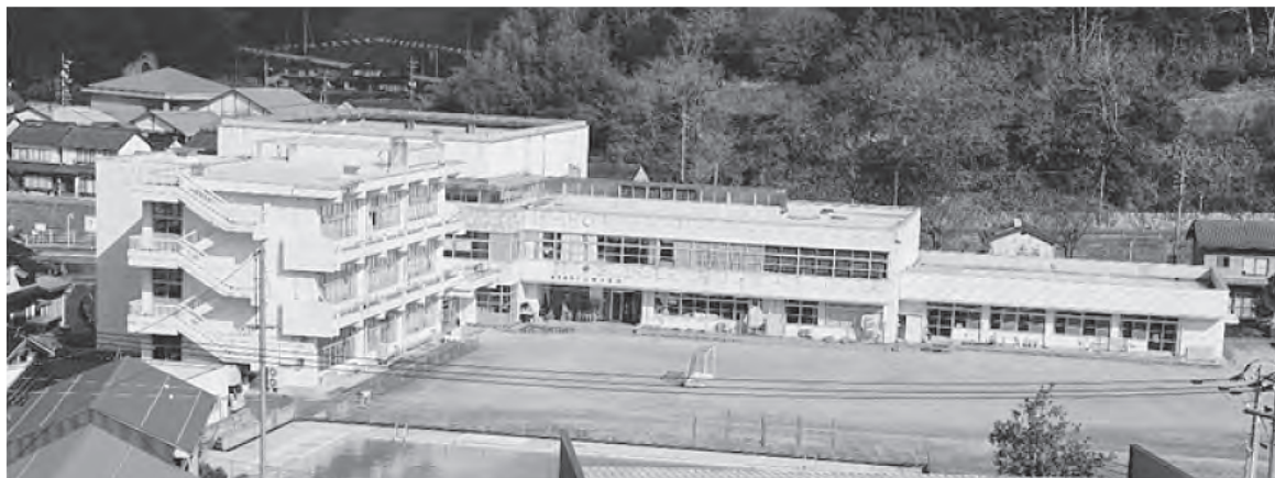
仁多地域統合小学校の建設地は現三成小学校敷地に
