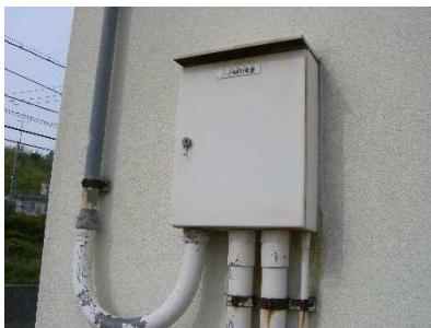
屋外盤類の開閉・施錠確認
