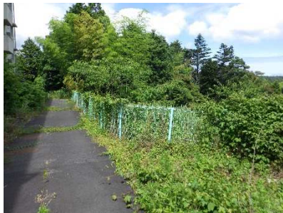
フェンスの破損・傾き
