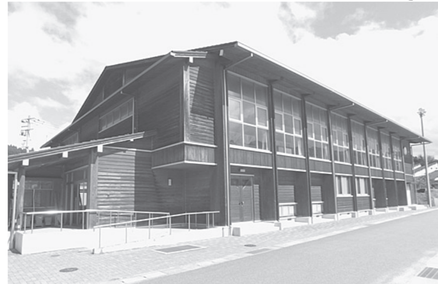
最大収容300人の亀高小体育館（指定避難所）
