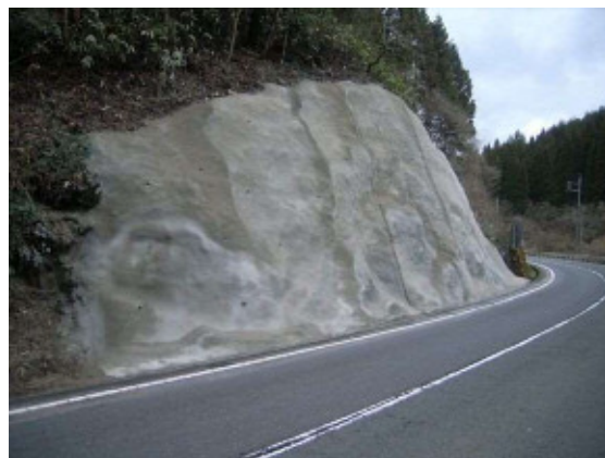
写真 3-1 既設モルタルの撤去+再吹付
