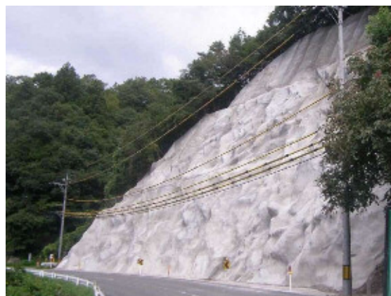
写真 3-2 繊維補強モルタル吹付
