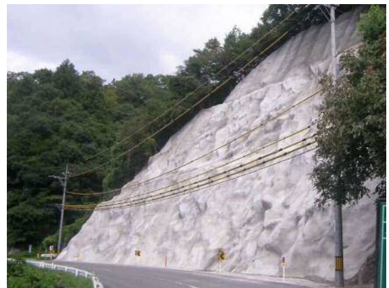
写真 3-2 繊維補強モルタル吹付
