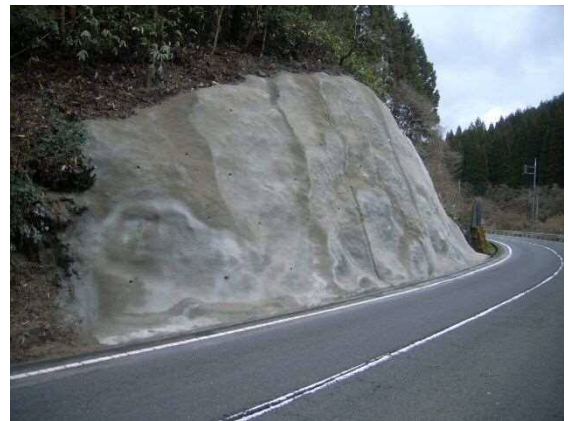
写真 3-1 既設モルタルの撤去＋再吹付
