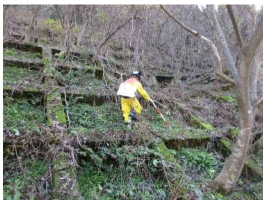
写真 2-1 法面等構造物点検状況
