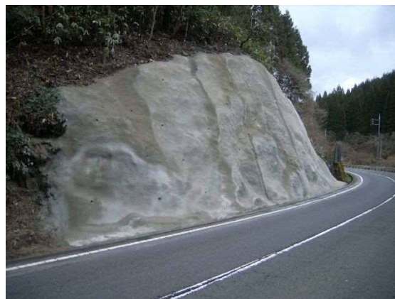
写真 3-1 既設モルタルの撤去＋再吹付
