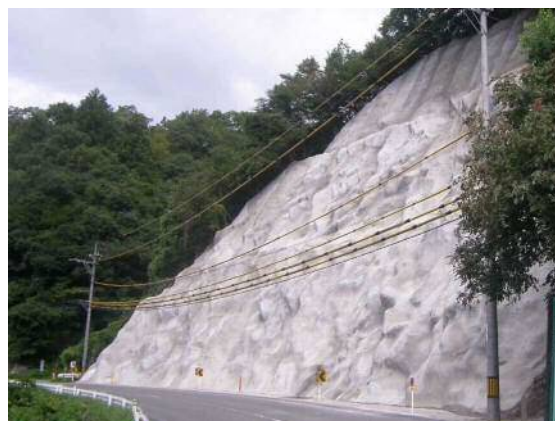
写真 3-2 繊維補強モルタル吹付
