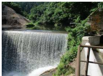
【取水ダム（県砂防堰堤）】
