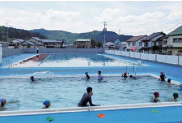
町立横田小学校プール
