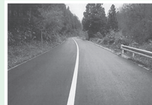
舗装改修を行った梅木原地内の道路
