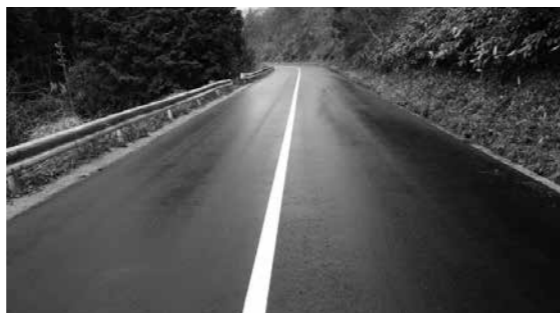
▲舗装改修を行った梅木原地内の道路
