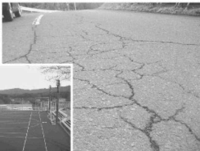
急がれる町道の舗装修繕
