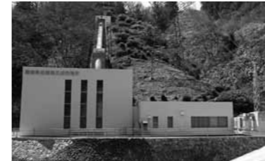
▲リニューアルされた三成発電所
