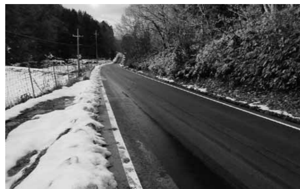
▲舗装改修を行った梅木原地内の道路
