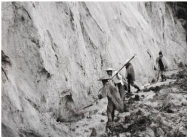
砂鉄を採取した「鉄穴流し」の歴史
