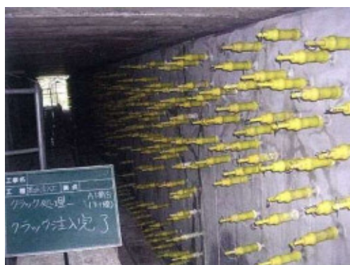
写真4-2 ひび割れ注入状況
