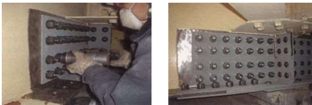
写真4-1 当て板工実施状況
