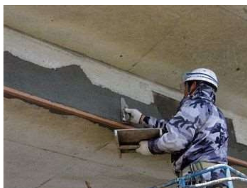
写真4-3 断面修復状況
