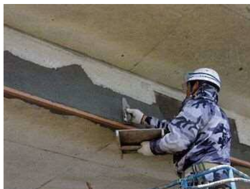
写真4-3 断面修復状況
