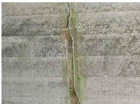
覆工（側壁）からの漏水
