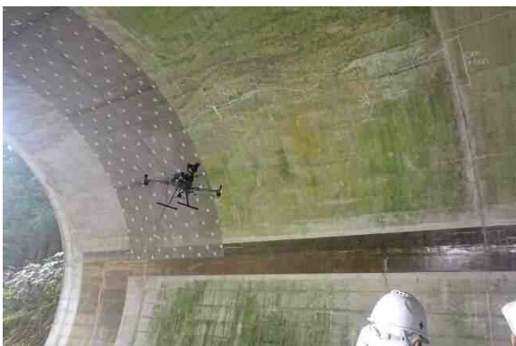
写真4-1 ドローン点検活用状況
