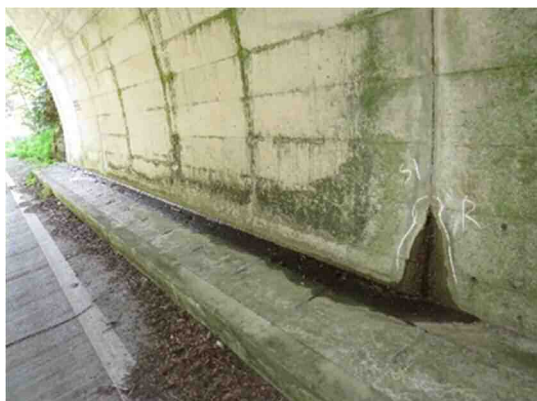
覆工（側壁）からの漏水
