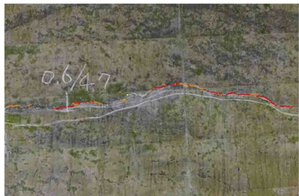
写真4-2 AI ひび割れ解析
