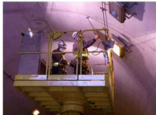
写真 2－1 トンネル点検状況
