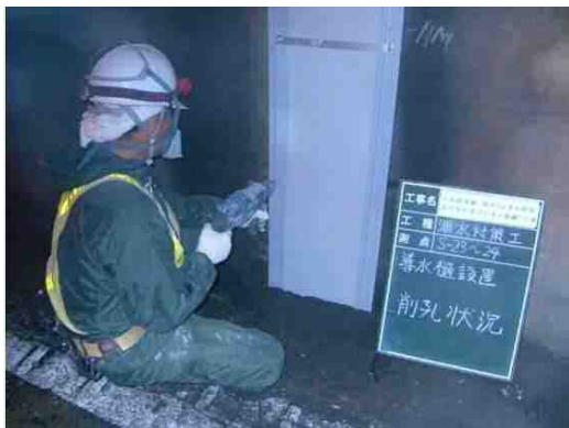
写真 3－2 線導水工
