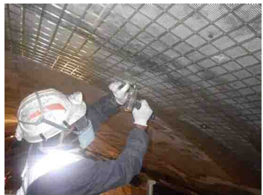
写真 3－1 FRP ネット設置状況
