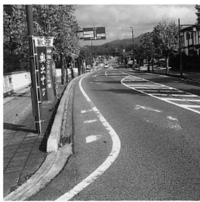
無電柱化が実施されているJR横田駅前街路
