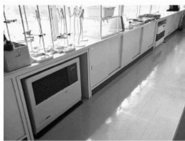
修繕される教室の暖房機器 今後エアコンの整備も必要となる
