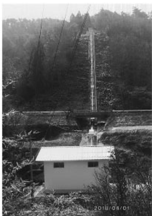
完成した阿井発電所
