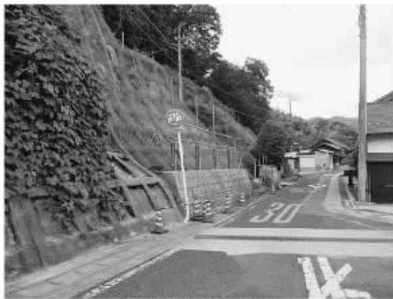
通学路災害復旧道路工事の様子
