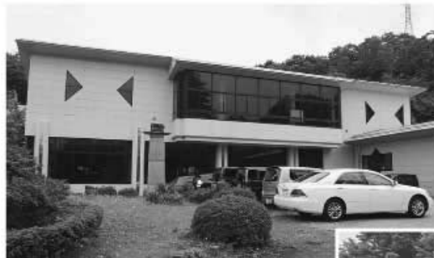
修繕される仁多中学校武道場
