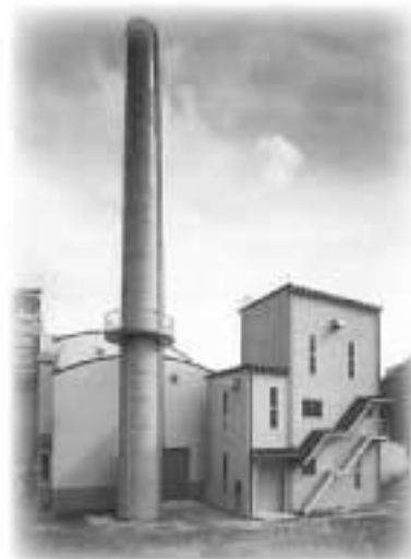
可燃物処理センター
