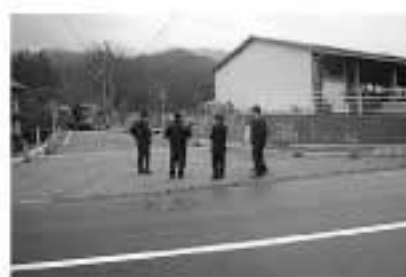
◎阿井幼稚園入口付近道路改良工事
