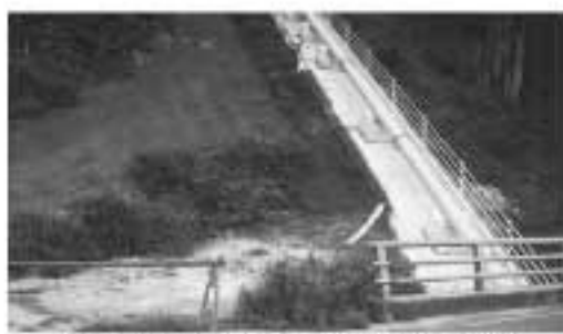
阿井地区川東で建設中の小水力発電所
