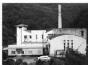
仁多可燃物処理センター
