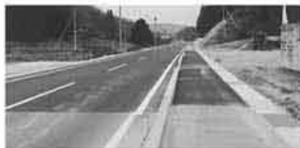
国道交通安全通学路整備
