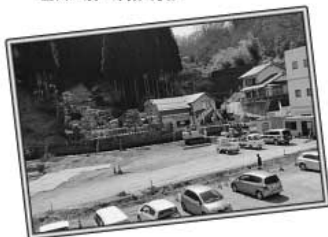
造成が進む「新仁多庁舎建設予定地」(現庁舎裏)
