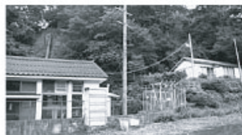
改築前の仁多発電所
