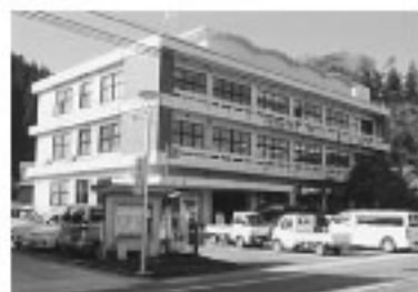
改築される現仁多庁舎
