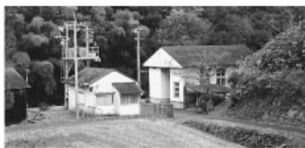
三沢小水力発電所(河内地内)
