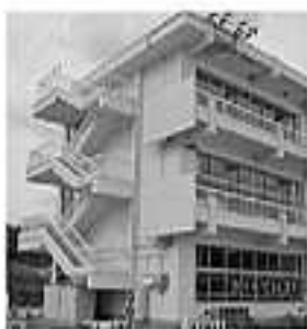
専決で使用できるようになった、三成小非常階段修繕
