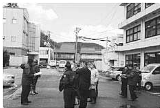
解体工事が進む仁多庁舎周辺。現庁舎の裏側が新庁舎の建設地となる。
