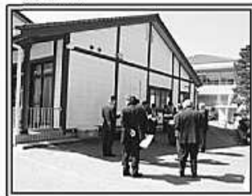
一体的活用のため改修予定 (手前：三成保育所、奥：三成児童館)
