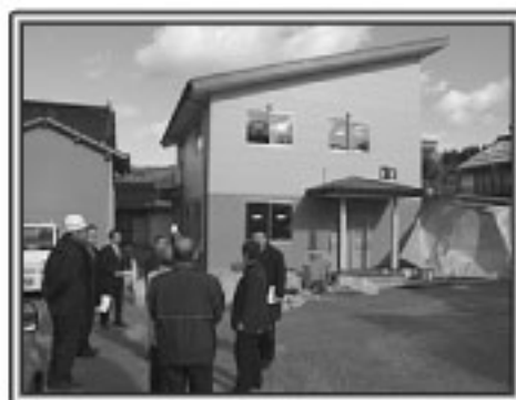
建設中の医師住宅
