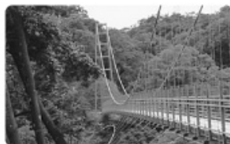
完成した舌震の恋吊橋
