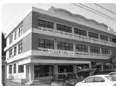
早期の耐震化・改築へ議論が必要な仁多庁舎
