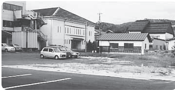
整地された旧横田幼稚園跡地
